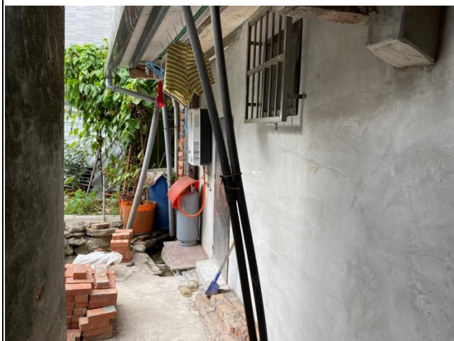
建物拆除後退縮空間確認照片(後巷尾)
