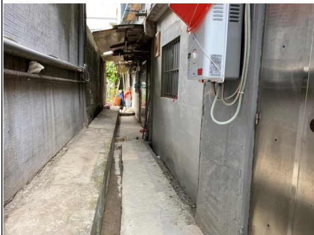
建物拆除後建物照片(後巷中)
