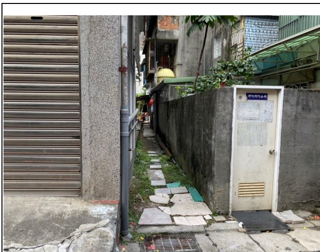
建物拆除後建物照片(後巷口)
