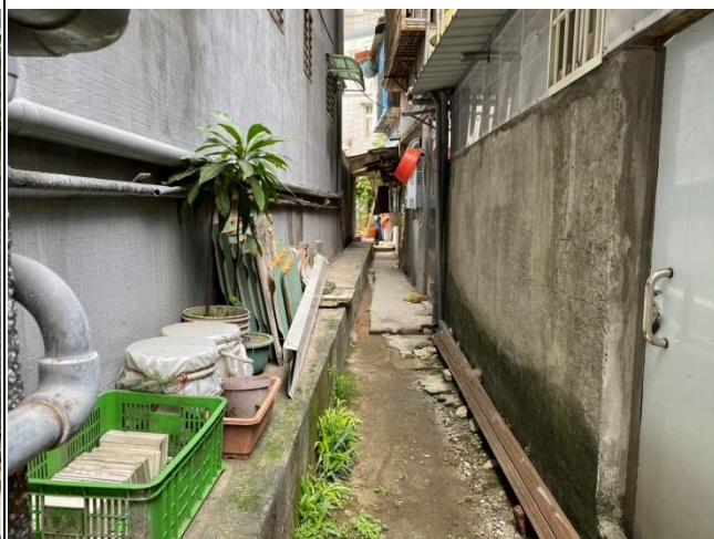
建物拆除後建物照片(後巷中)
