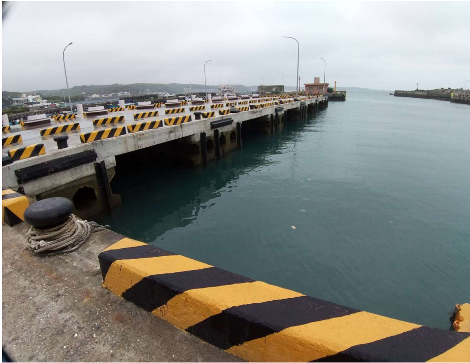
富基漁港水環境營造改善工程施工後相片
