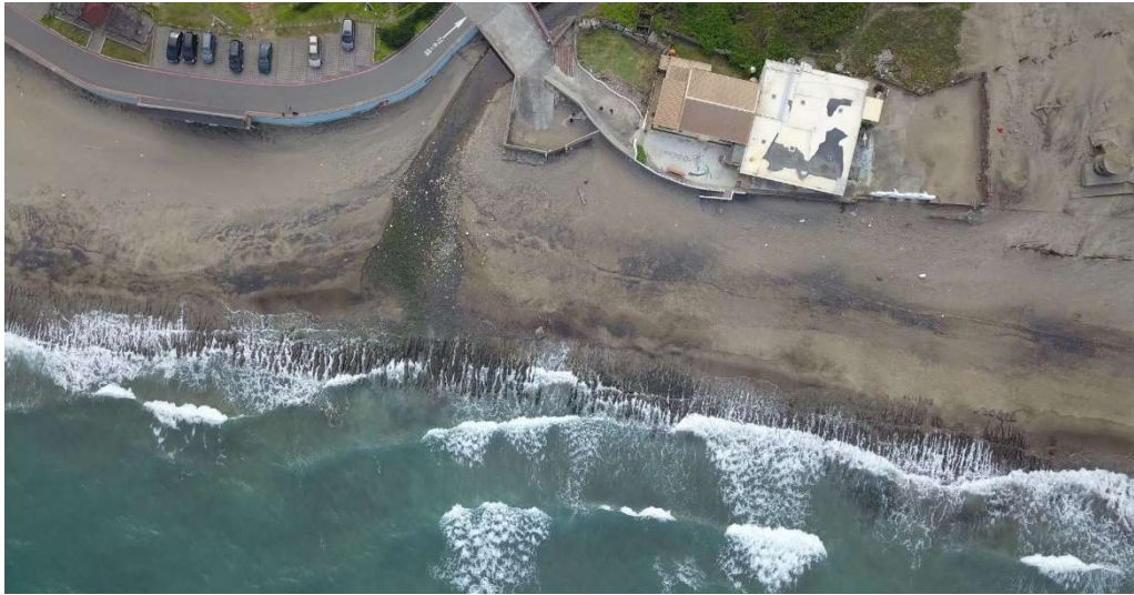
老梅漁港施工後照片
