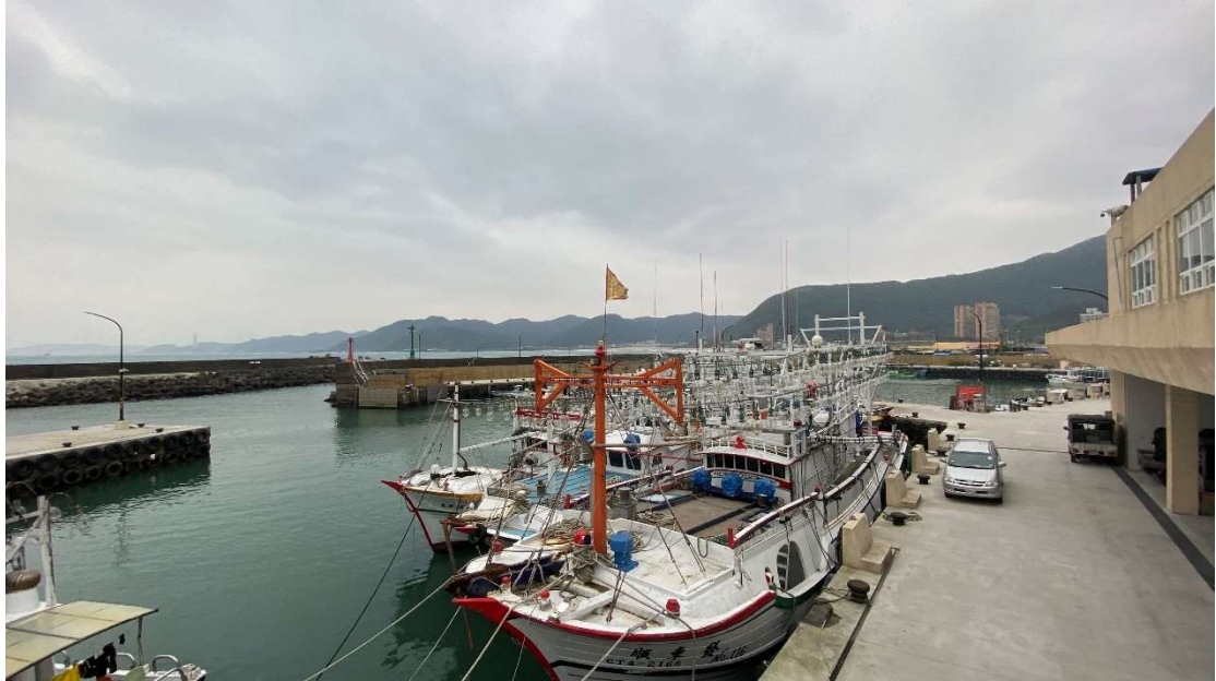
龜吼漁港水環境營造改善工程-完工照片 1
