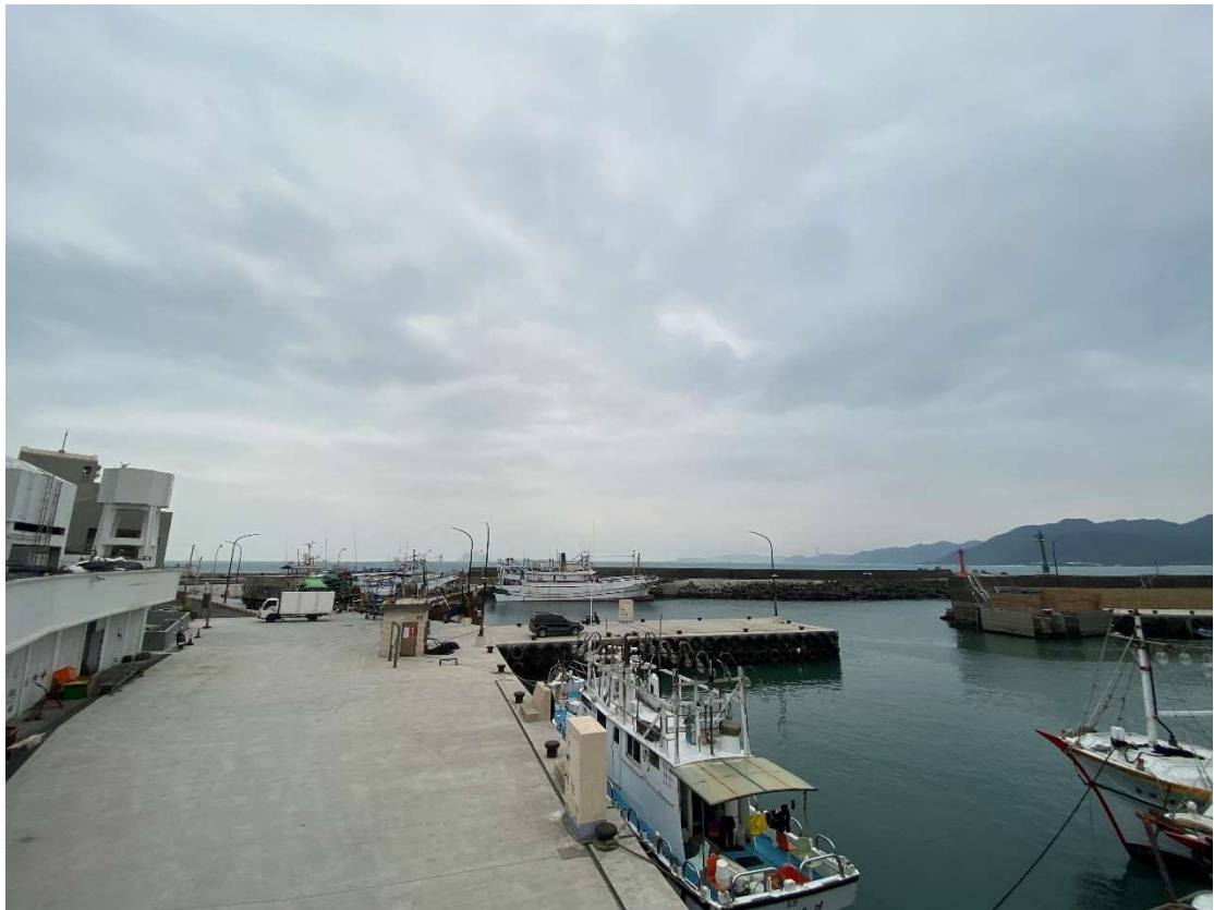
龜吼漁港水環境營造改善工程-完工照片 2
