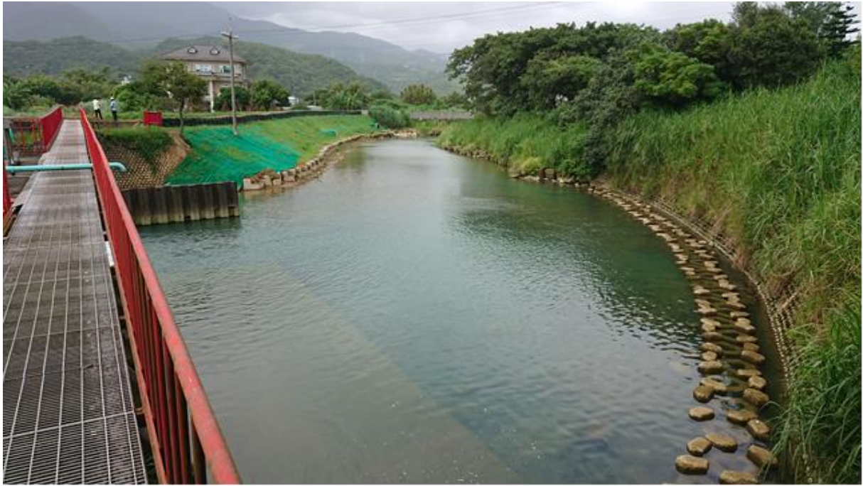
水岸及護坡照片
