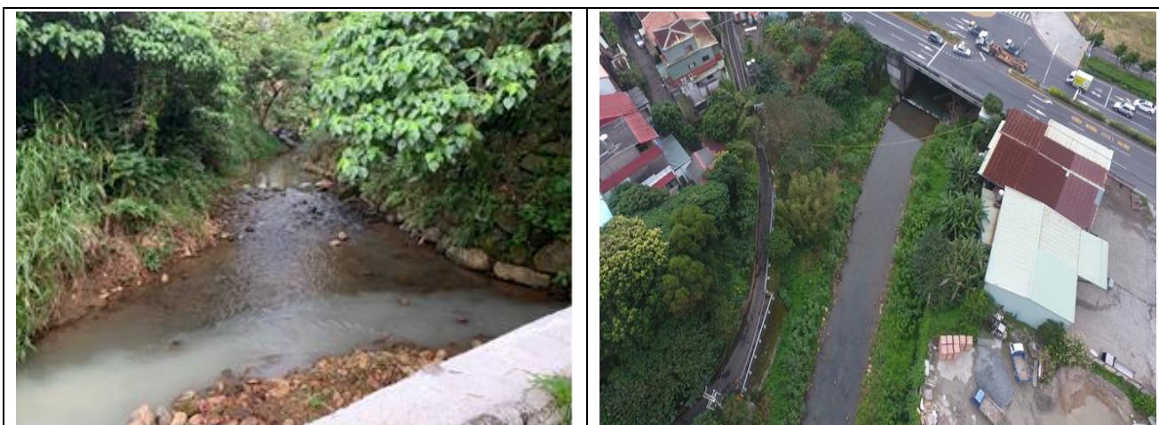
水岸及護坡照片
