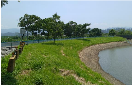
工程環境現況
