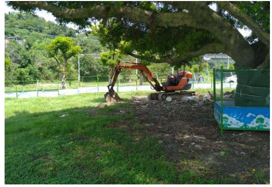
工程環境現況
