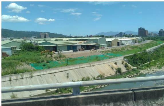
工程環境現況
