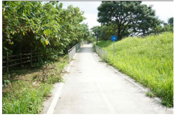
工程環境現況
