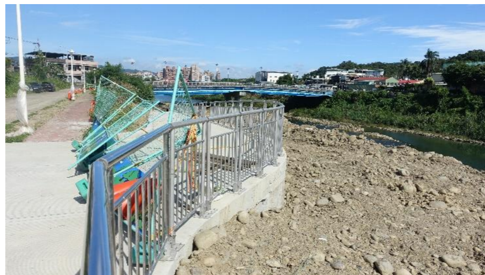
施工設施照片
