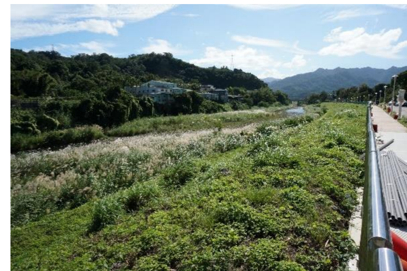
上游段水岸及護坡
