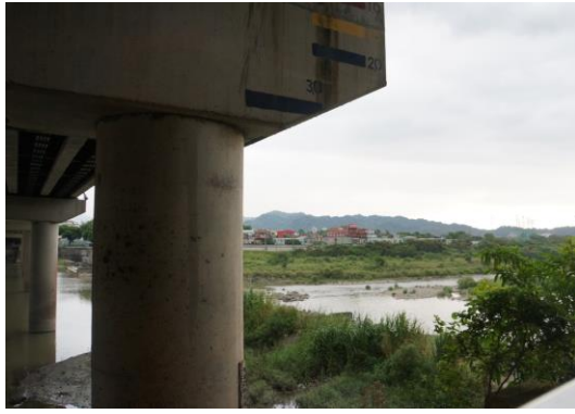
工程環境現況
