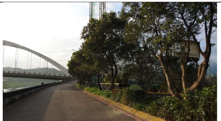
環境照-計畫區休憩廊道旁之行道樹
