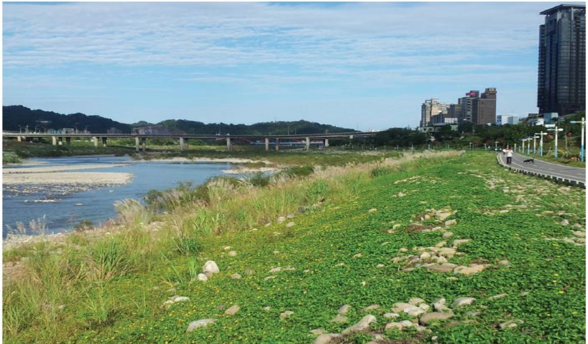
圖 3 新店溪河畔現況照片(1)
