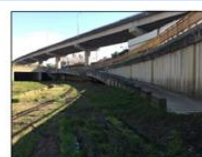
4.下河床斜坡道
