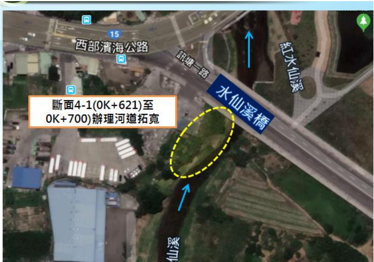
水仙溪橋(第二下厝橋)段河道瓶頸改善工程
