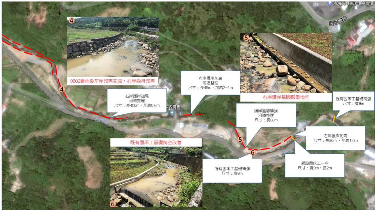
石門區石門溪護岸改善暨瓶頸段應急工程
