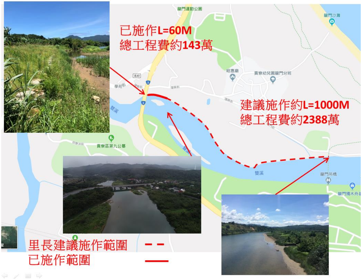
雙溪河龍門橋至龍門吊橋護岸延長工程
