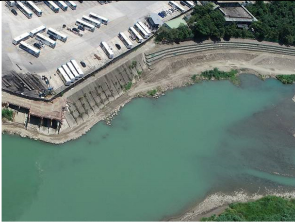
邊坡護岸多為水泥面
