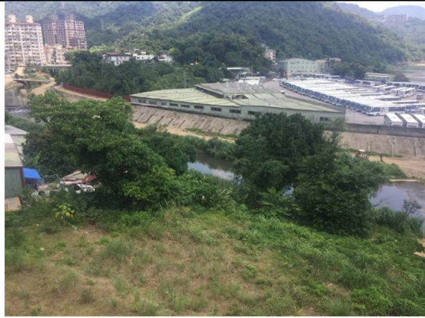
邊坡護岸多為水泥面
