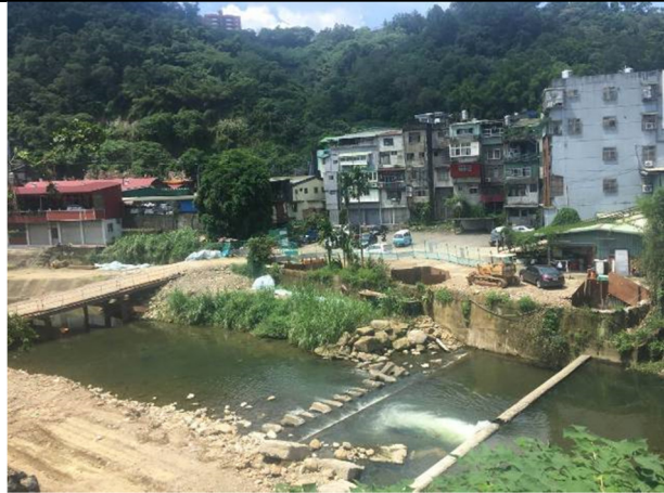
青潭橋旁橫向人造設施及施工便橋
