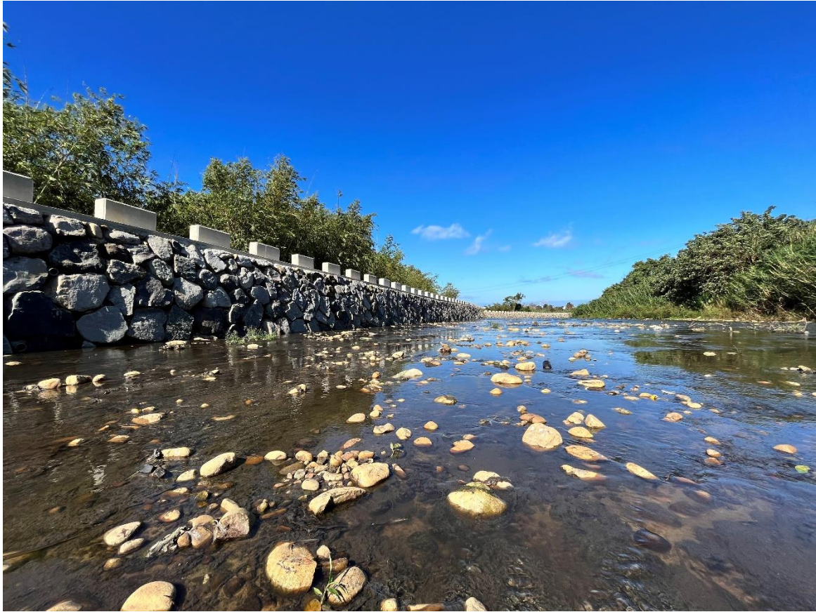
圖二 八里區水仙溪田心仔橋至長道坑二號橋護岸應急工程(110 年度)
