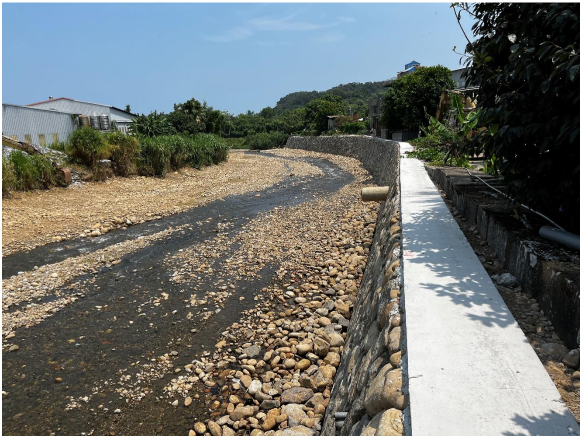
圖三 八里區水仙溪長道坑二號橋至 2 號無名橋間護岸改善應急工程(111 年度)
