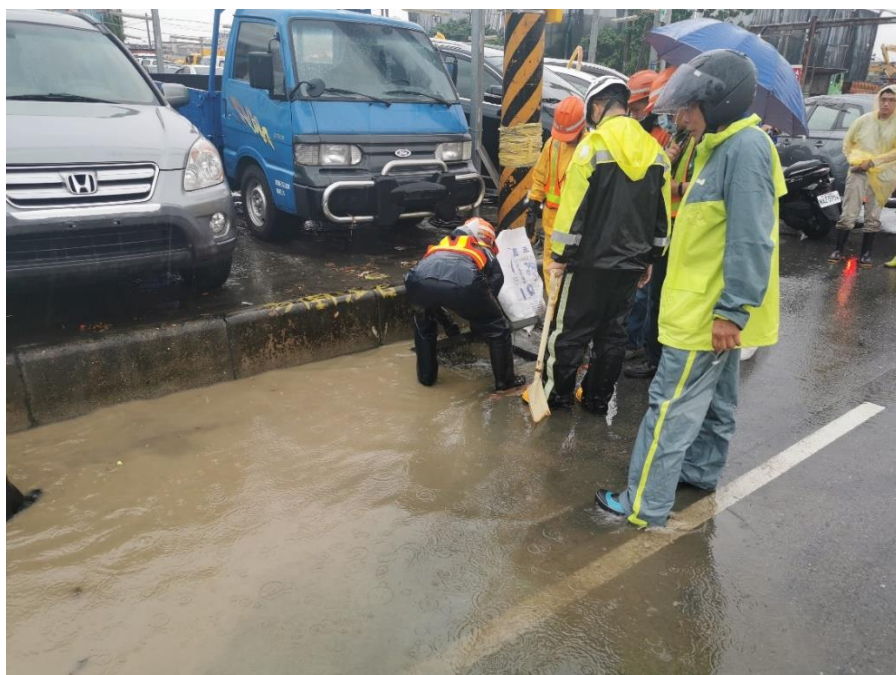
圖一 暴雨導致側溝排水不及
