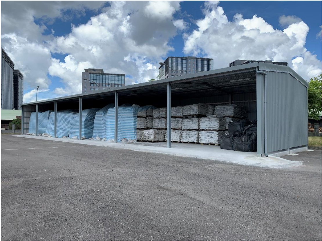
圖四 五股抽水站防汛備料棚架
