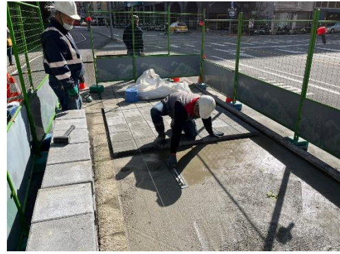
圖 15 中港大排人行道地磚修繕
