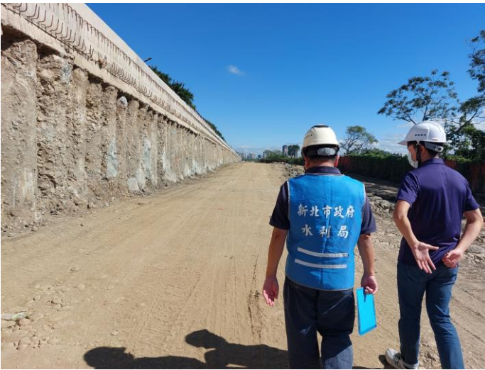
大漢溪堤外水岸廊道串聯暨周邊環境改善工程-新建堤外便道工程
