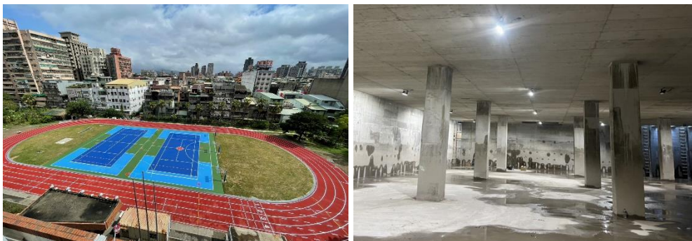
新北市三重區正義國小透水保水工程
