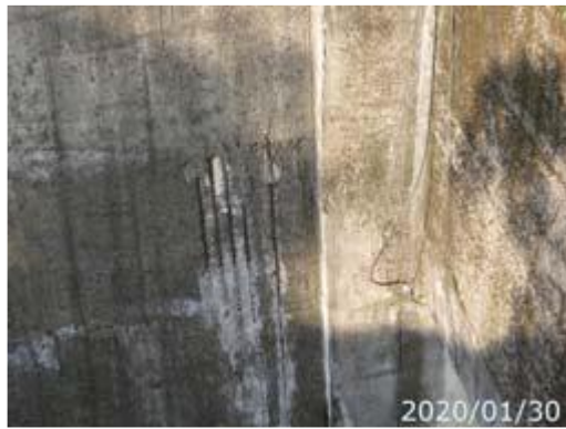
圖 4 水利建造物表面鋼筋裸露(圖 4)
