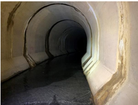
圖 5 分洪設施結構裂縫滲水
