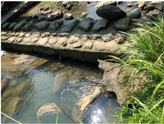
圖 3 護岸基腳、固床工掏空
