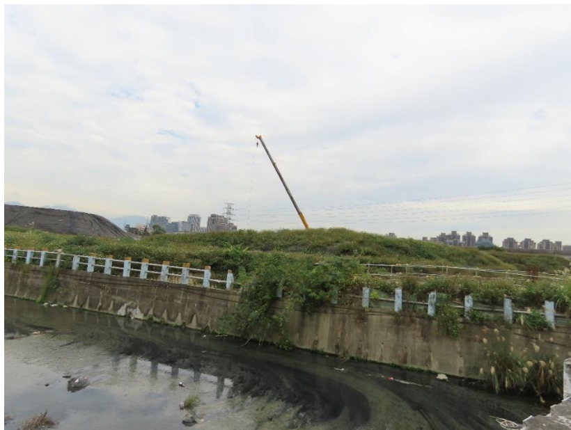
圖 2.2 貴仔坑溪現況
